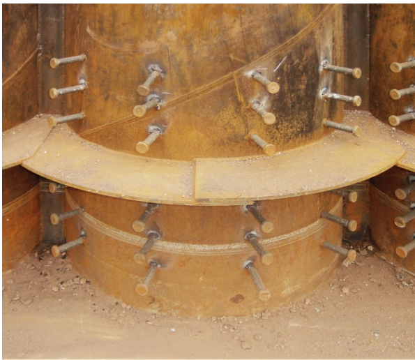
Figure 22 Slab Connection Details (Tubular Pile) – 2
