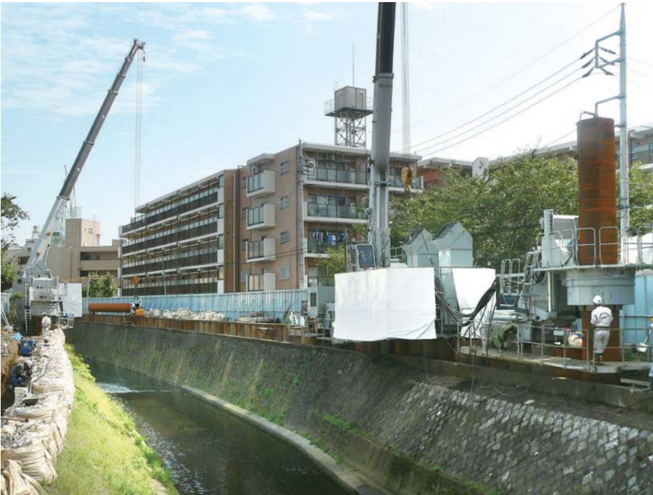
采用了旋转压入工法的住宅地周边护岸整備工程
